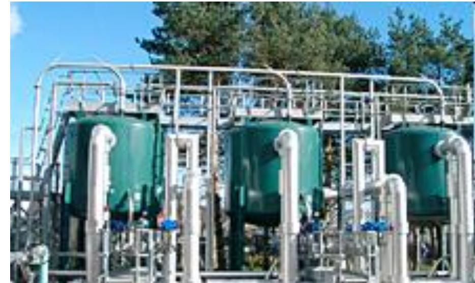
*Postrojenje i pilot postrojenje za tretman vode za piće sa reaktorom sa nepokretnim slojem granulisanog medija Bayoxide E33*
