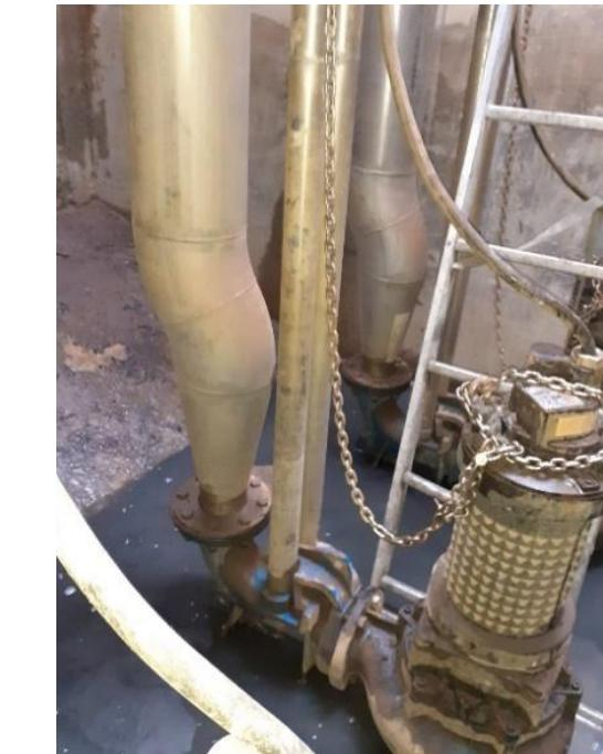
**Slika:** Ulazna CS sa novim muljnim pumpama
