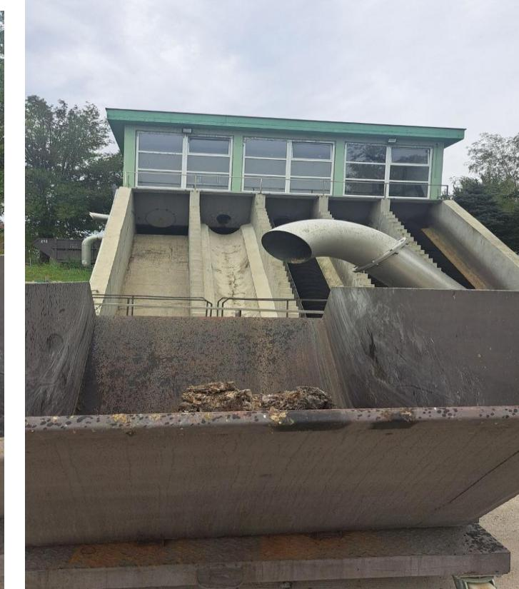
**Slika:** Presa sa kontejnerom kod grube rešetke
